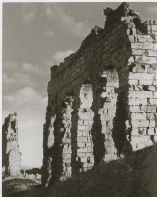
Руины водопровода Калигулы около Рима
